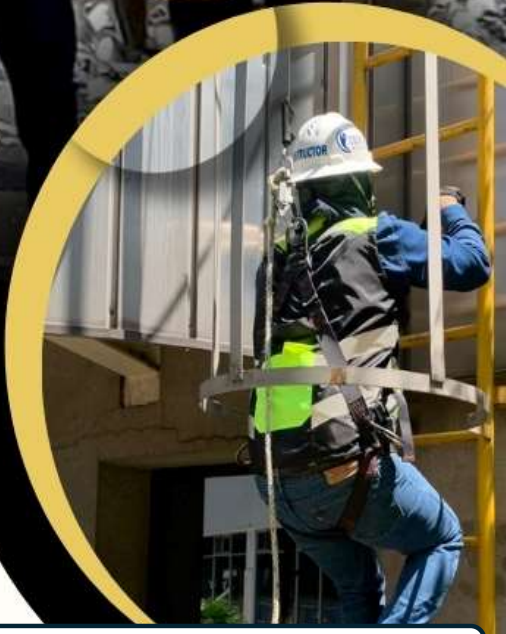
TRABAJOS EN ALTURA
